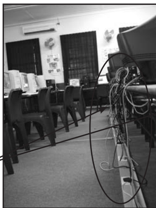
Foto 3: Elektriese gevare
